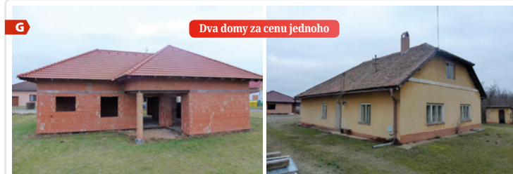
Dva domy za cenu jednoho Prodej dvou rodinných domů na větším pozemku, Křovice Jedná se o starší přízemní dům 4+1, hrubou stavbu domu 4+1 a hospodářskou stavbu. Starší rodinný dům je ihned obývatelný s nutností modernizací. Domy se nacházejí v krásné lokalitě nedaleko řeky Dyje a cca 10 km východním směrem od Znojma a Národního parku Podyjí. N/RSB/17720/19 4 900 000 Kč
